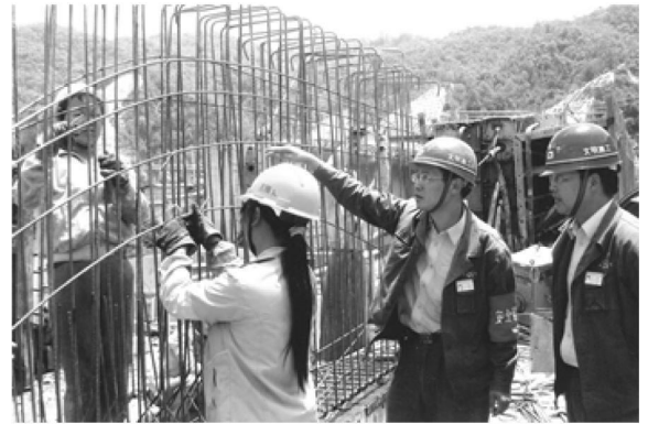
图2 保龙高速公路正在建设的大桥 Fig.2 The of BaoLong expressway in construction
