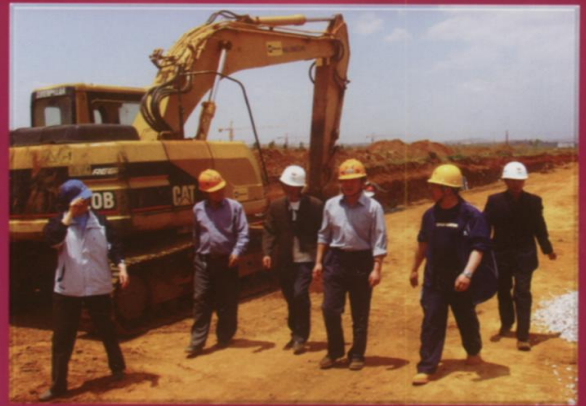
周荣校长到呈贡新校区指导工作并视察基础设施施工
