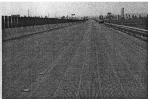
图1 曲陆高速公路下行线路面磨损情况
